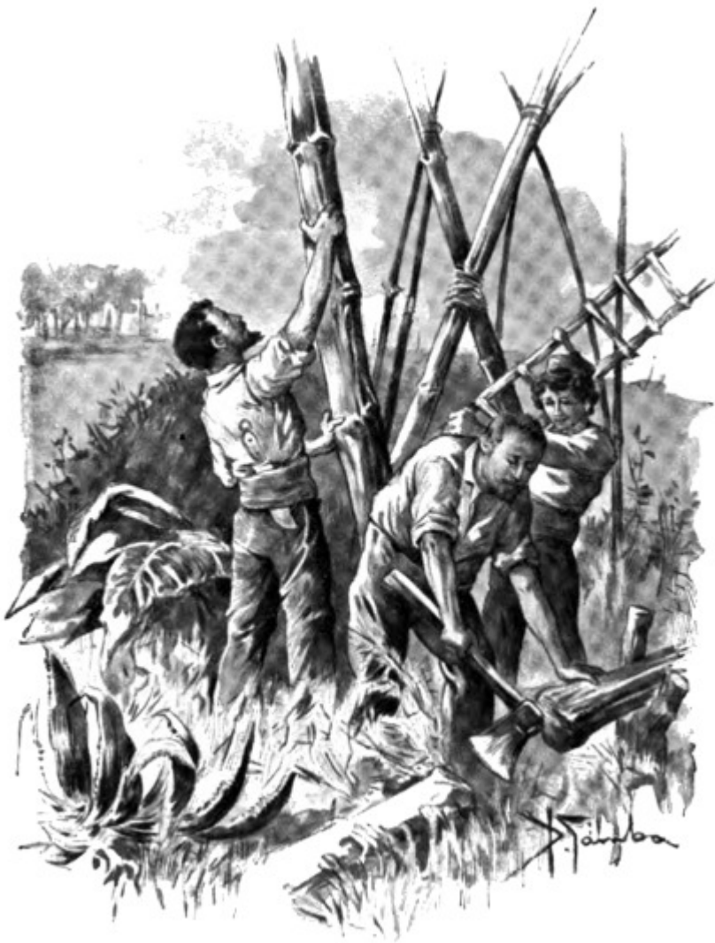
Costruzione della capanna aerea. (Pag. 50 ).
